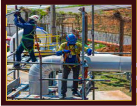
أعمال البنية التحتية Infrastructure works
