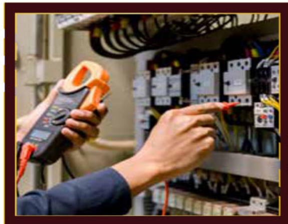
أعمال الكهرباء Electrical works
